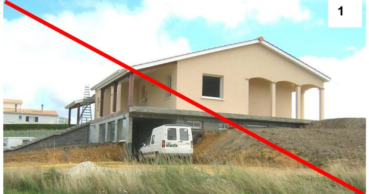
Implantation sur plateforme sur-élevée, importants mouvements de terrains
